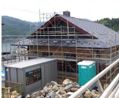
資材の規格が同じなので、建設 スピードがきわめて速い (2018 年 6 月 雄勝地区)
