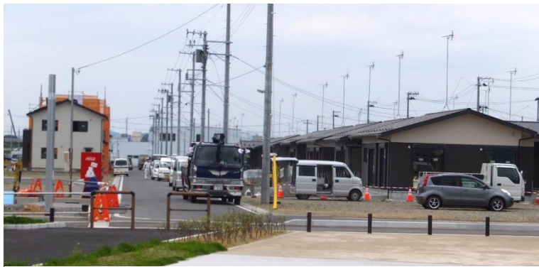
次々と建設されていく復興住宅 (2018 年 6 月 二子中央地区)
