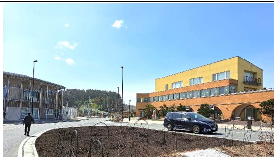
双葉町駅（常磐線）の駅前ロータリー。建設中の施設が各所に見られる
